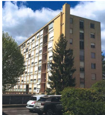
Résidence Chateaubriand avant rénovation
