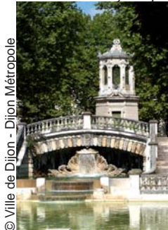
Réservoir Darcy - Dijon
