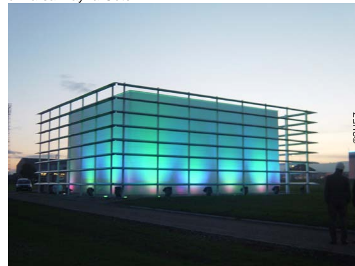
Usine de traitement de la Rente Logerot à Marsannay-la-Côte
