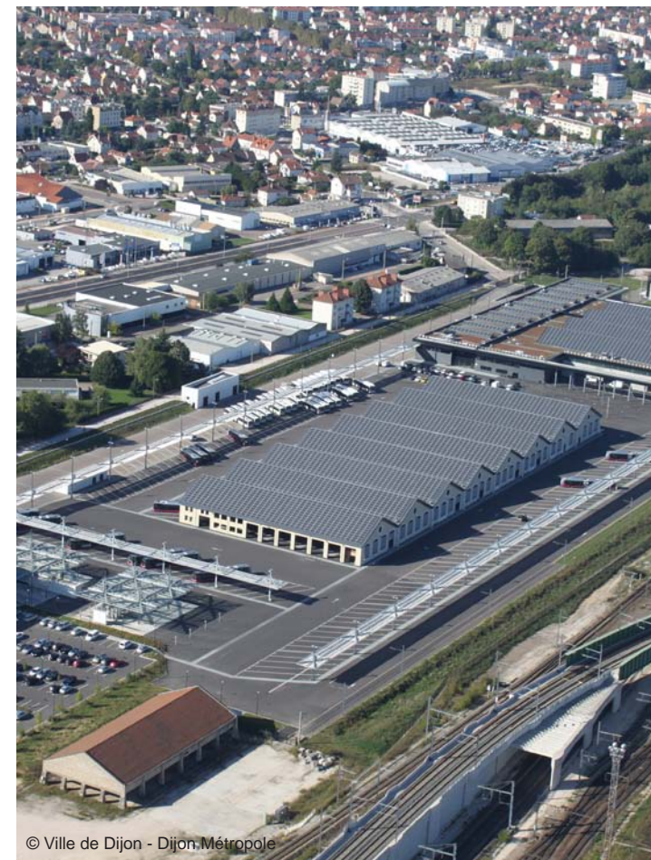
Centre de maintenance du tramway - Dijon
