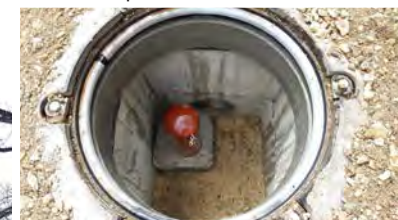
Pose d'un piézomètre
