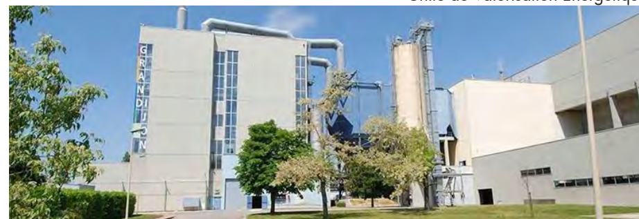
Unité de Valorisation Énergétique
