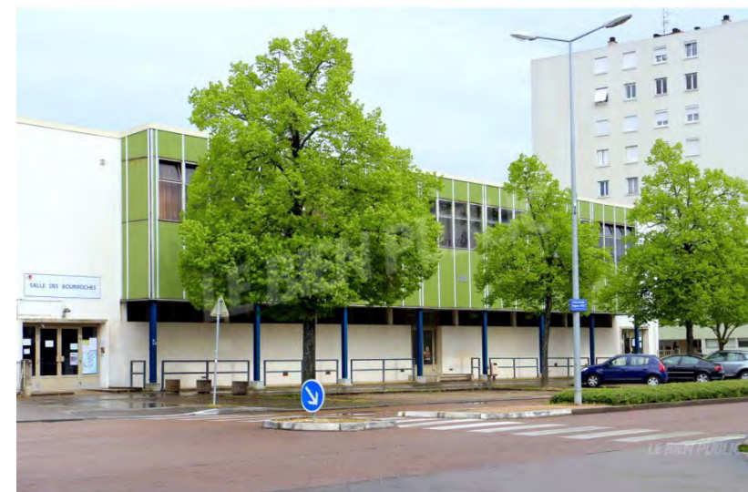
Gymnase des Bourroches
