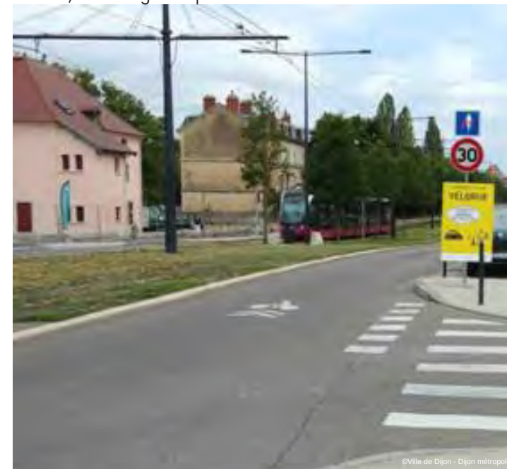
Vélorue, rue Monge à Dijon
