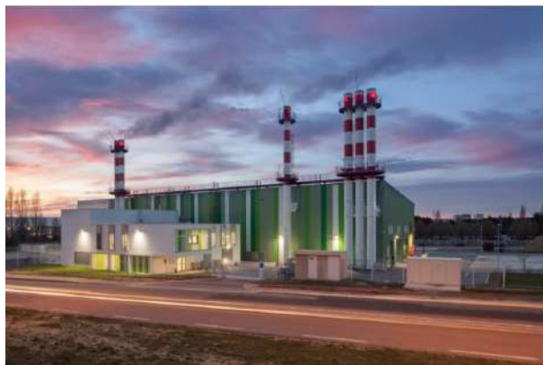
Chaufferie des Péjoces – Dijon Energies
