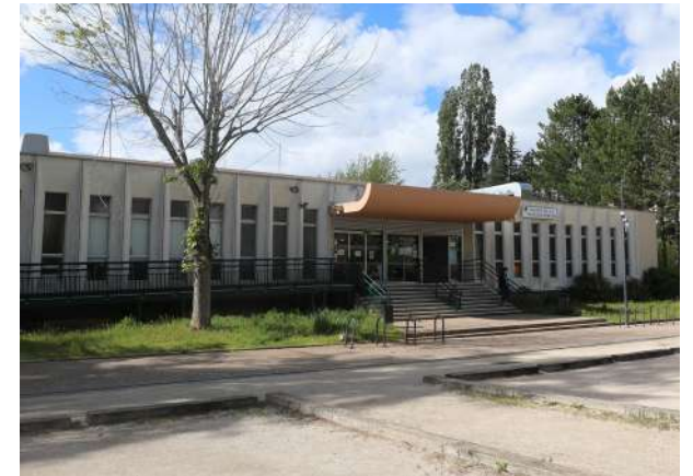
Piscine de la Fontaine d'Ouche – ©DavidVong
