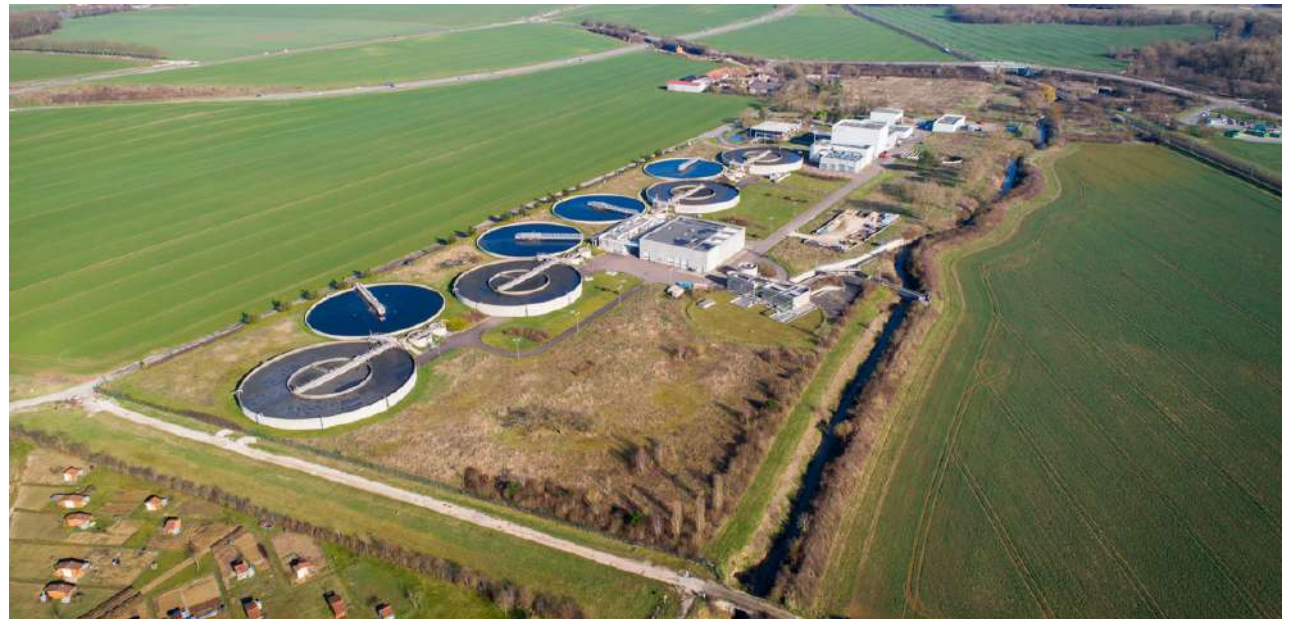
Station d'épuration à Longvic _©Christophe Fouquin
