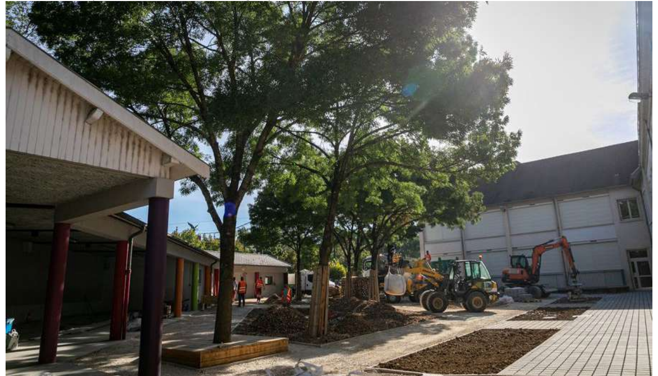
Travaux de désimperméabilisation de la cour du groupe scolaire Nord – ©David Vong
