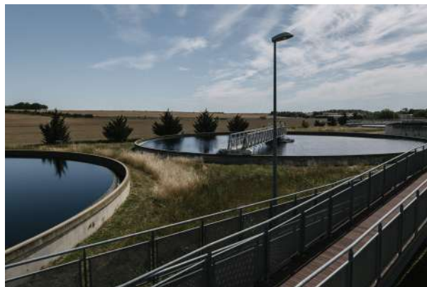
Station de traitement des eaux usées Eau Vitale de Dijon-Longvic ©Jonas Jacquiel
