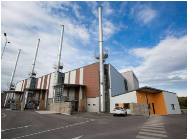
Chaufferie des Valendons - SODIEN
