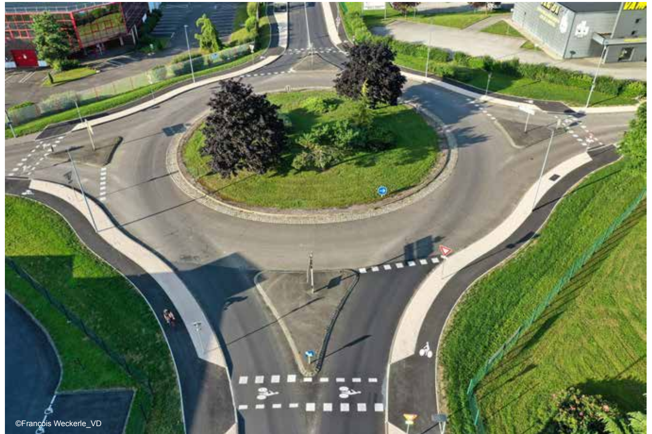
Aménagement de piste cyclable entre Sennecey et Chevigny Saint Sauveur.
