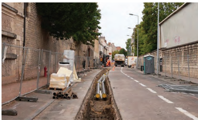
Travaux pour le RCU ©Emma Benyamine /VD
