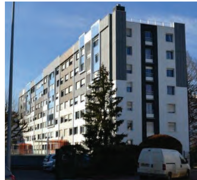
Résidence Chateaubriand - Après - Rénovation BBC - 84 logements ©VD/DM
