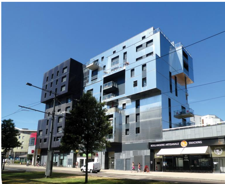
Avenue Jean Jaurès Opération EMIN promoteur, Résidence Services Séniors « Les Séniors », 69 logements Maître d'oeuvre : Tridon Architecture (Dijon)
