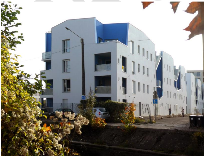
Ecoquartier Arsenal Opération Grand Dijon Habitat couplant 32 logements en accèsion abordable à la propriété et 30 logements à loyer modéré Maître d'œuvre : Studiomustard (Dijon)
