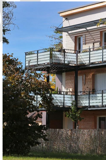
Ecoquartier Montmuzard Opération Habellis de 12 logements Maîtres d'œuvre : IXO Architecture (Sélestat) et François Lausecker (Gérardmer)
