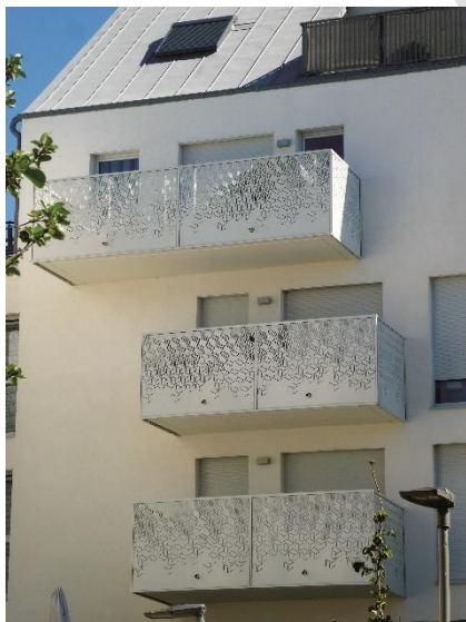
Ecocité Jardins des Maraichers Opération Habellis de 54 logements Maître d'œuvre : Calc, atelier d'architecture (Dijon)
