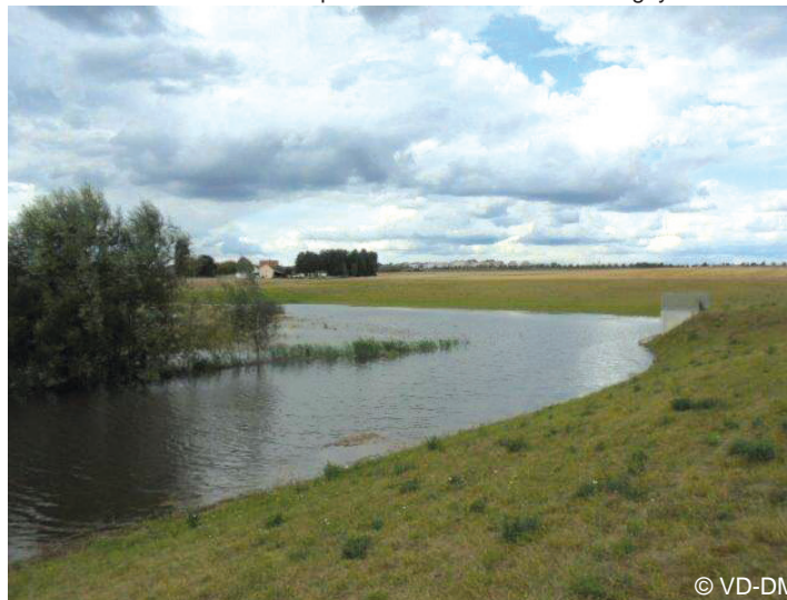
Bassin de rétention des eaux pluviales des Collines à Quetigny
