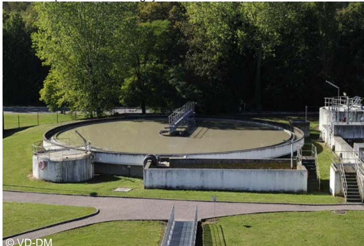
Station d'épuration de Chevigny Saint Sauveur
