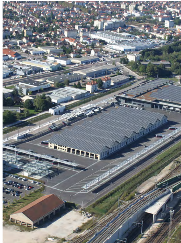
Centre de maintenance du tramway - Dijon
