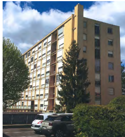
Résidence Chateaubriand avant rénovation
