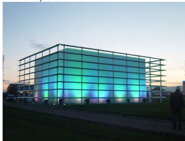
Usine de traitement de la Rente Logerot à Marsannay-la-Côte
