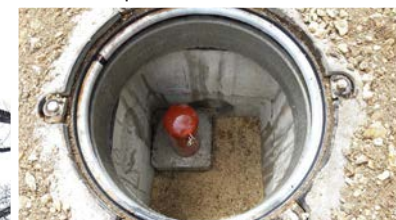
Pose d'un piézomètre
