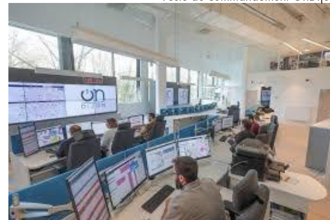
Poste de commandement OnDijon
