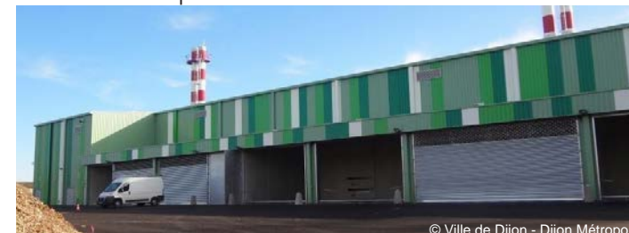
Chaufferie des Péjoces
