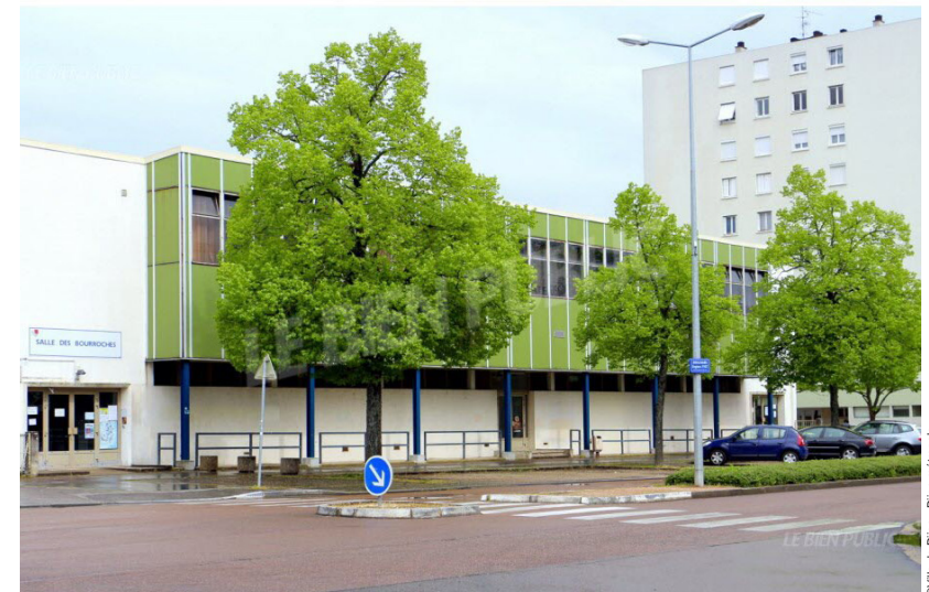
Gymnase des Bourroches
