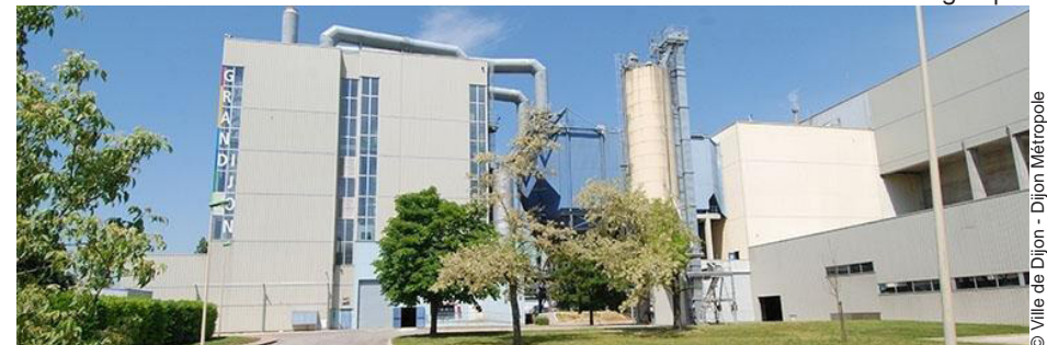
Unité de Valorisation Énergétique
