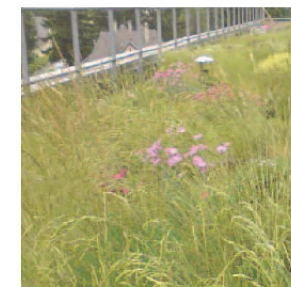
Toitures terrasse semi-intensive
