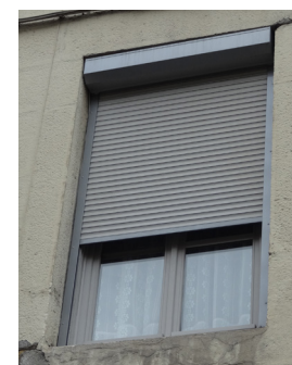
à coffrage extérieur
