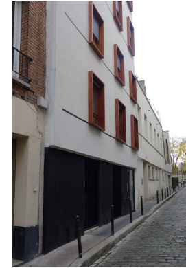
Ex : isolation et réinterprétation des encadrements de baie
