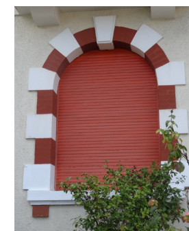
à coffrage intérieur
