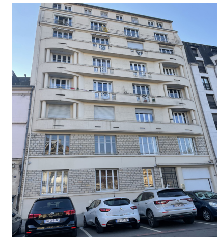
Exemple de toiture "effacée" sur bâtiment style Art Déco
