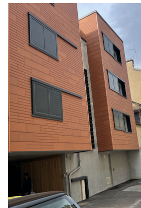
Façade en terre cuite
