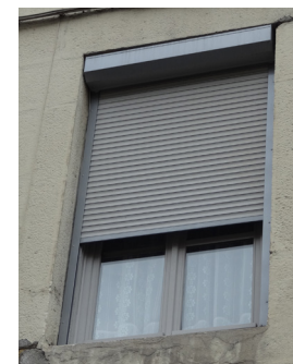
à coffrage extérieur
