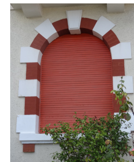
à coffrage intérieur
