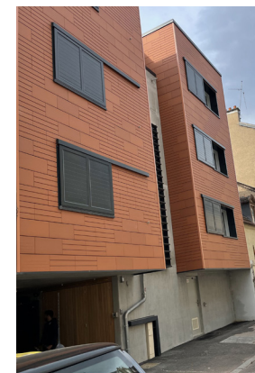
Façade en terre cuite
