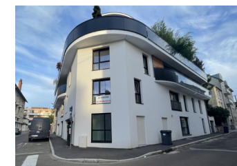
Façade en béton peint
