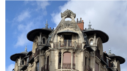
Exemple de toiture exubérante, style Art Nouveau
