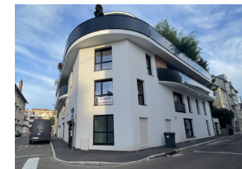
Façade en béton peint
