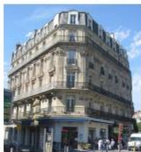
Immeuble de type haussmannien
