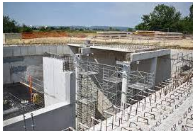
Construction d'un second bassin d'orage pour réduire les déversements
