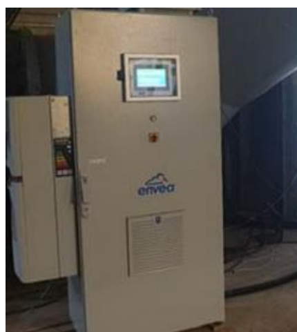
Analyseurs de mercure en test à l'UVE de Dijon métropole
