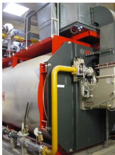
Constituée de 2 chaudières mixtes gaz/fioul domestique d'une puissance unitaire de 10 MW, cette chaufferie récupère également une partie de la chaleur issue de la combustion des déchets de l'usine d'incinération de Dijon Métropole au moyen d'échangeurs d'une puissance totale de 15 MW.
