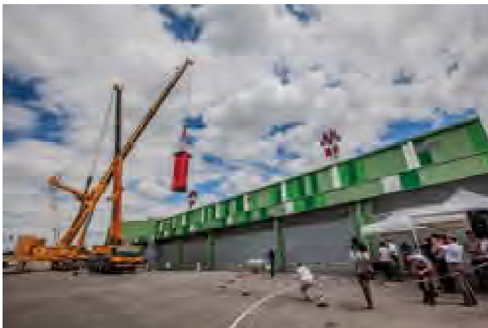
Grutage de l'économiseur de chaleur
