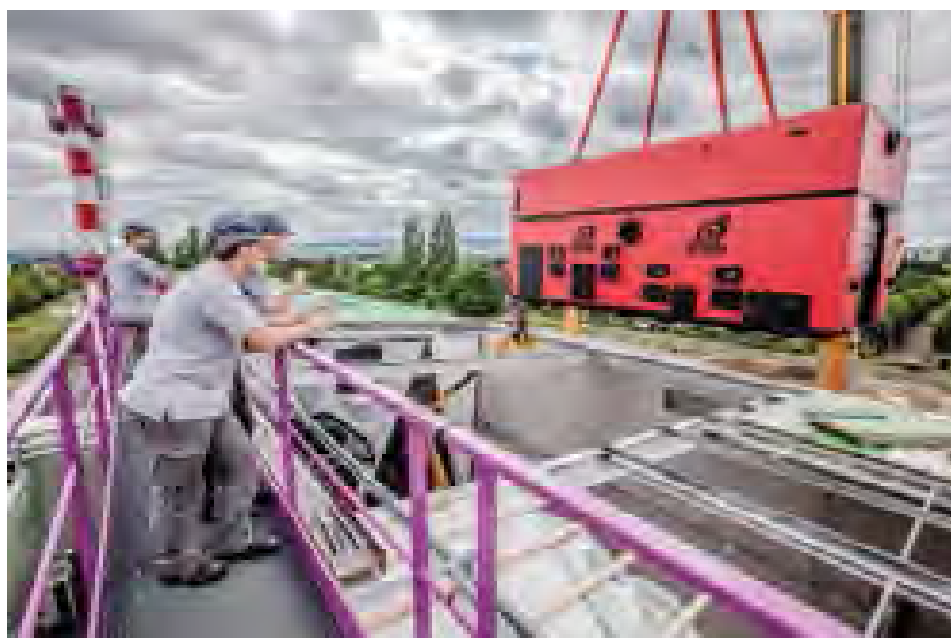
Grutage d'un des étages de combustion
