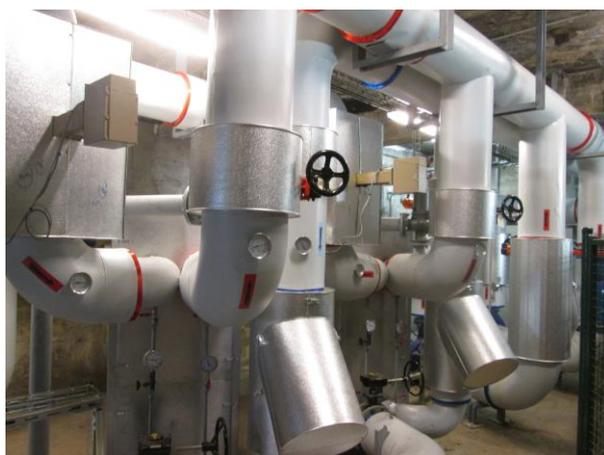
**Sous station CHU Bocage : 2 échangeurs de 8 MW**
