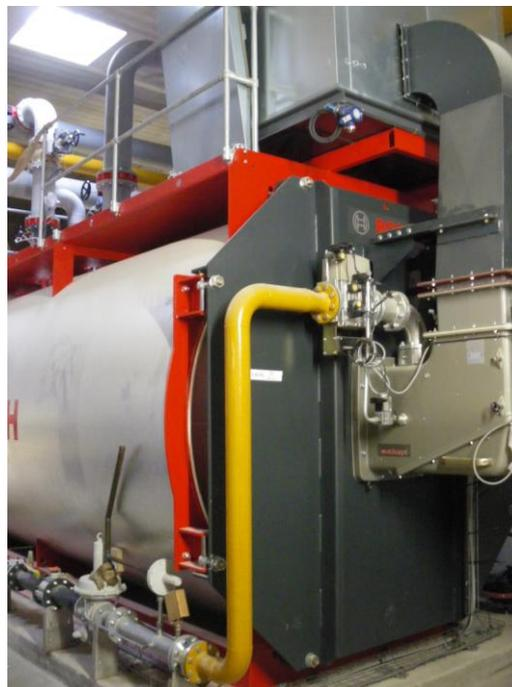
Constituée de 2 chaudières mixtes gaz/fioul domestique d'une puissance unitaire de 10 MW, cette chaufferie récupère également une partie de la chaleur issue de la combustion des déchets de l'usine d'incinération du Grand Dijon au moyen d'un échangeur d'une puissance de 9 MW.
