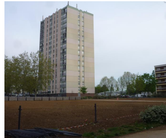
Emprise libérée par la démolition de la Tour Renan n°12
