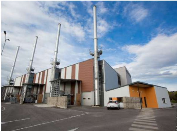
Chaufferie des Valendons - SODIEN
