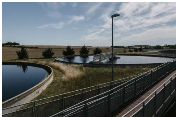
Station de traitement des eaux usées Eau Vitale de Dijon-Longvic ©Jonas Jacquet
