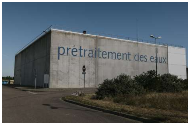
Station de traitement des eaux usées Eau Vitale de Dijon-Longvic ©Jonas Jacquet
