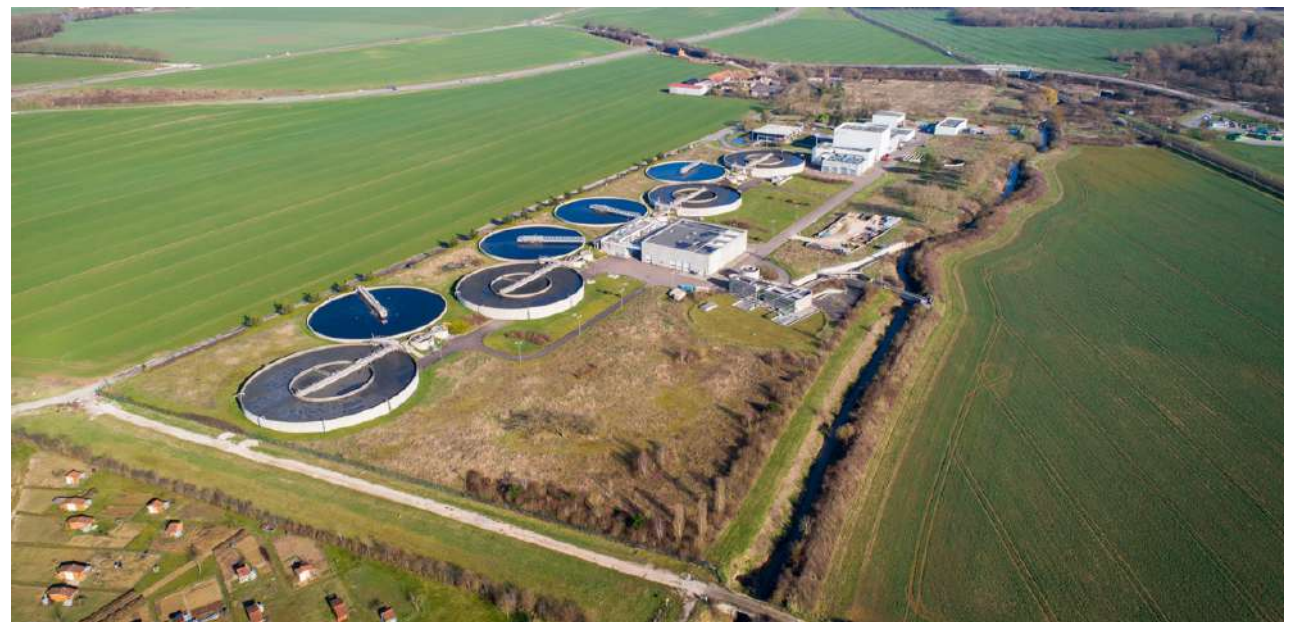
Station d'épuration à Longvic _@Christophe Fouquin
