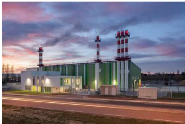
Chaufferie des Péjoces – Dijon Energies
