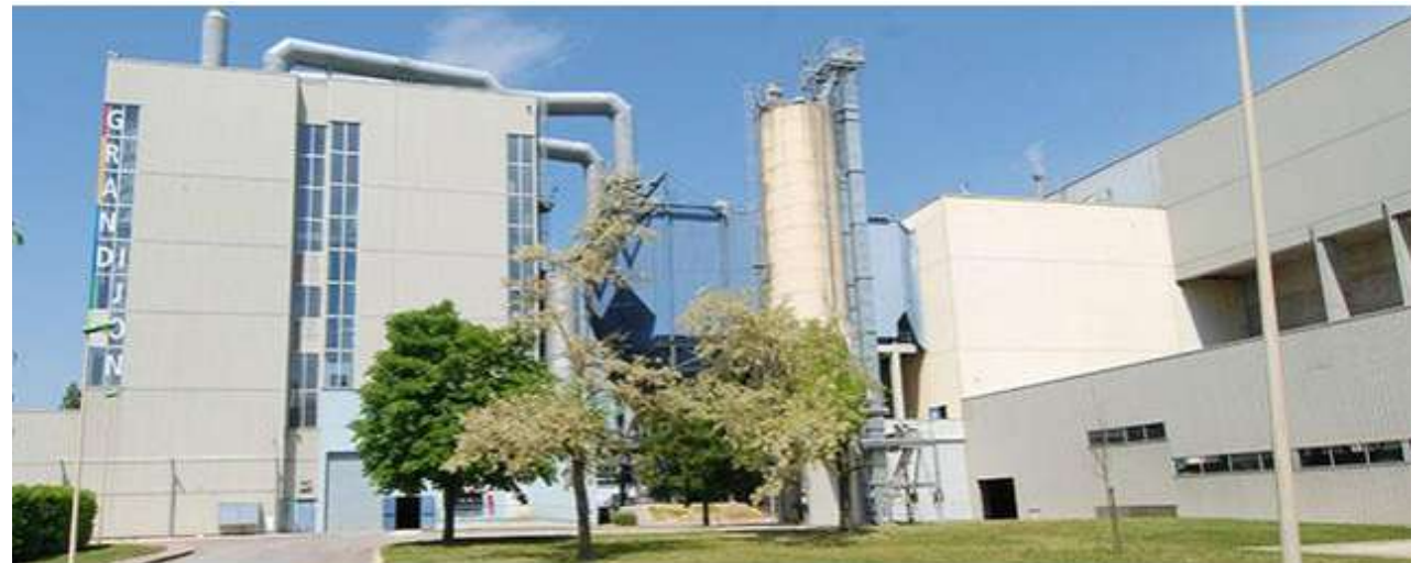
Unité de Valorisation Energétique – Dijon Métropole
