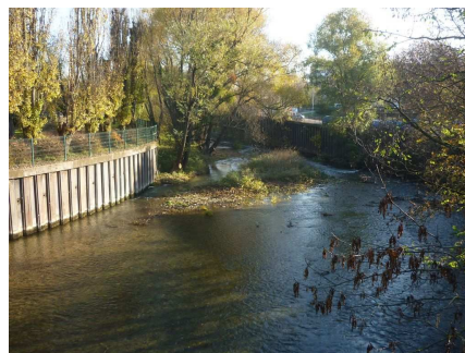
L'Ouche au niveau du Collège du parc
