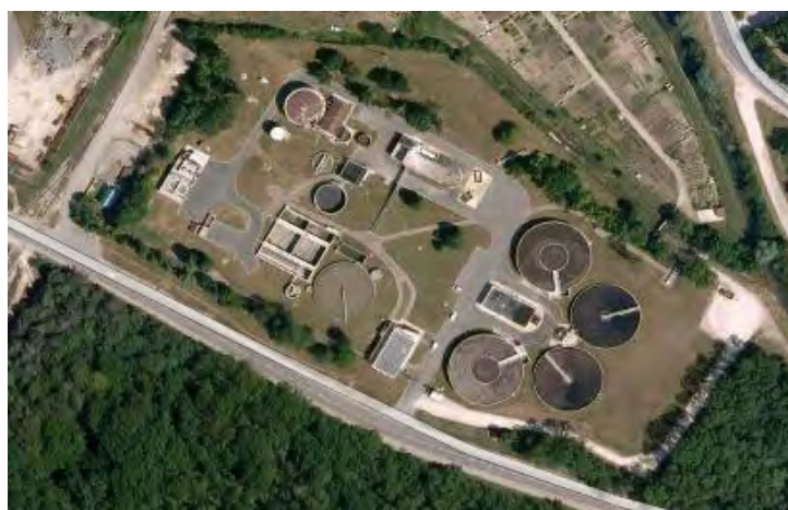
La station d'épuration de Chevigny-Saint-Sauveur
