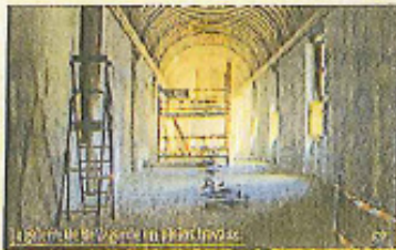
Le chantier a permis de dessiner les contours du futur musée des Beaux-Arts de Dijon.
