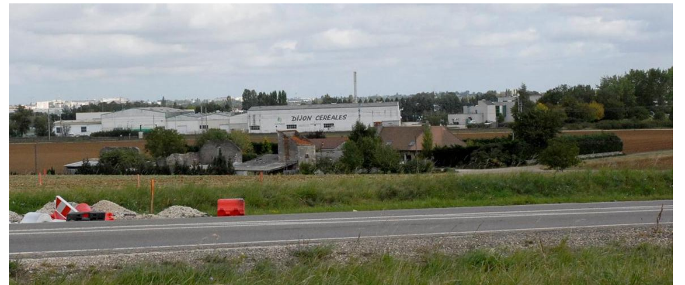
Vue en direction de la ferme de Coron depuis la limite Ouest du site de projet, en bordure de RD122A
