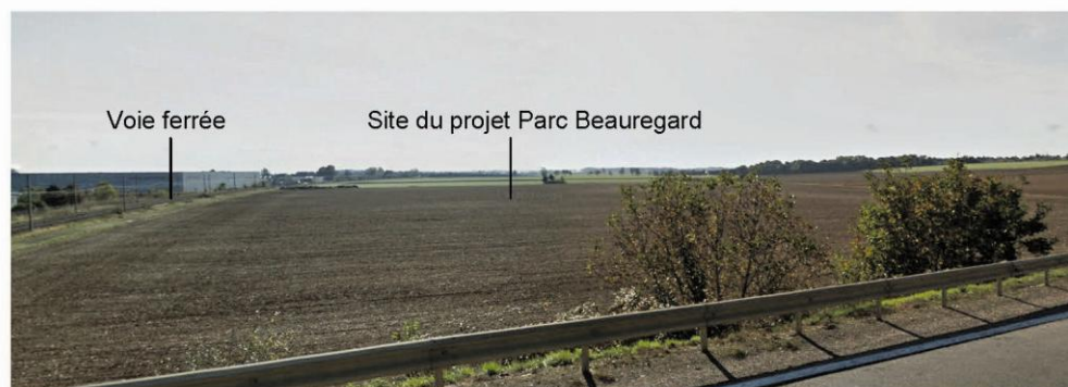
Vue du Nord-Est vers le Sud-Est : passage de la RD 122 A au dessus de la voie ferrée
