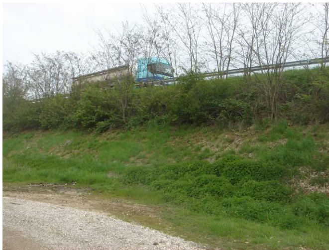
Talus au droit de la RD122a
