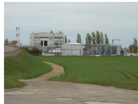
Bâtiment de la zone industrielle
