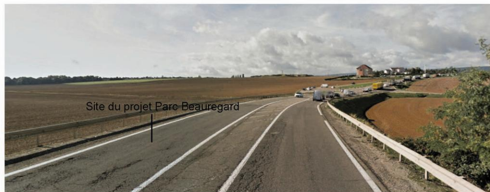
Vue du Nord-Est vers le Sud-Ouest : passage de la RD 122 A au dessus de la voie ferrée
