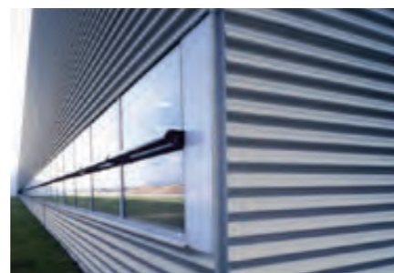
Bardage métallique ondes trapézoïdales
