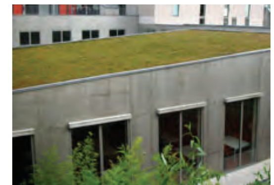
Toit terrasse végétalisé
