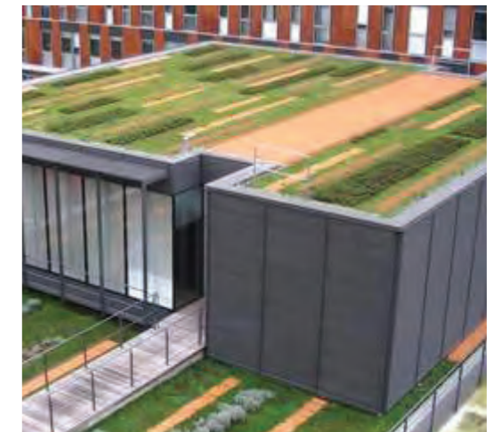
Toit terrasse végétalisé
