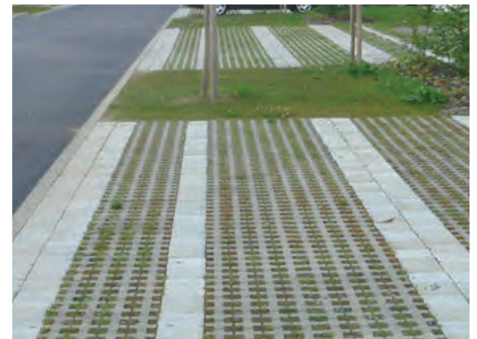
Exemple de revêtement poreux pour le stationnement: béton et dalles gazons
