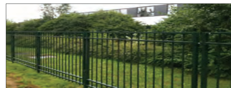
Clôture à barreaudage métallique droit sans mur bahut
