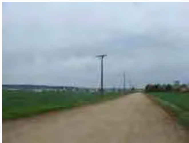
Ligne électrique le long de chemin menant au fort de Beauregard
