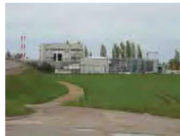
Bâtiment de la zone industrielle
