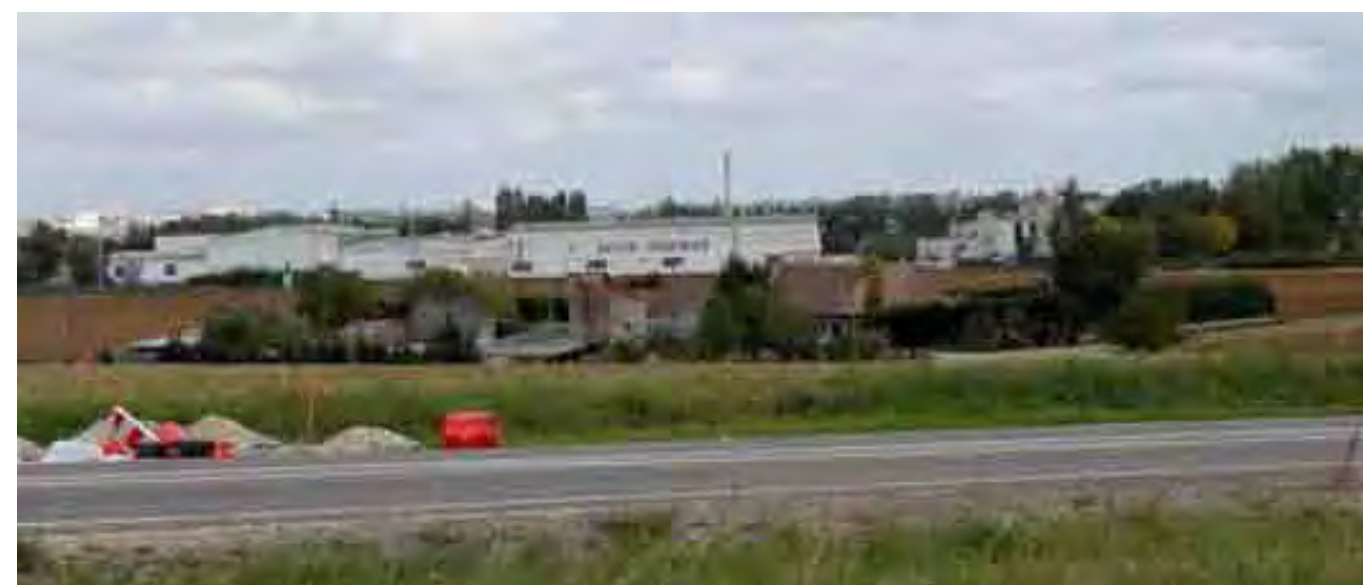
Vue en direction de la ferme de Coron depuis la limite Ouest du site de projet, en bordure de RD122A
