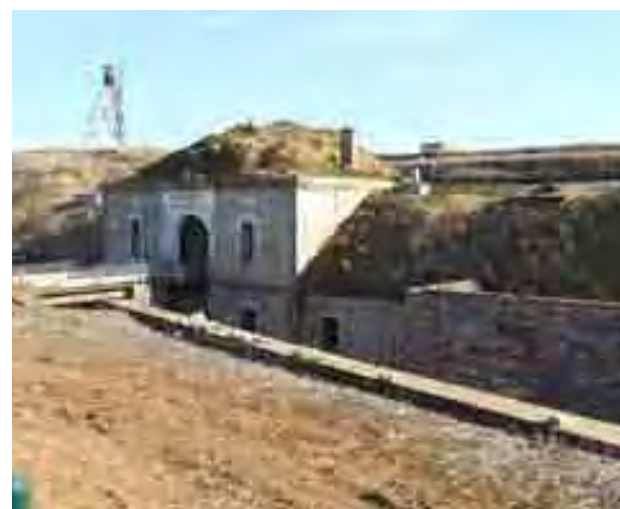
Entrée du Fort de Beauregard
