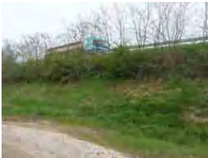
Talus au droit de la RD122a
