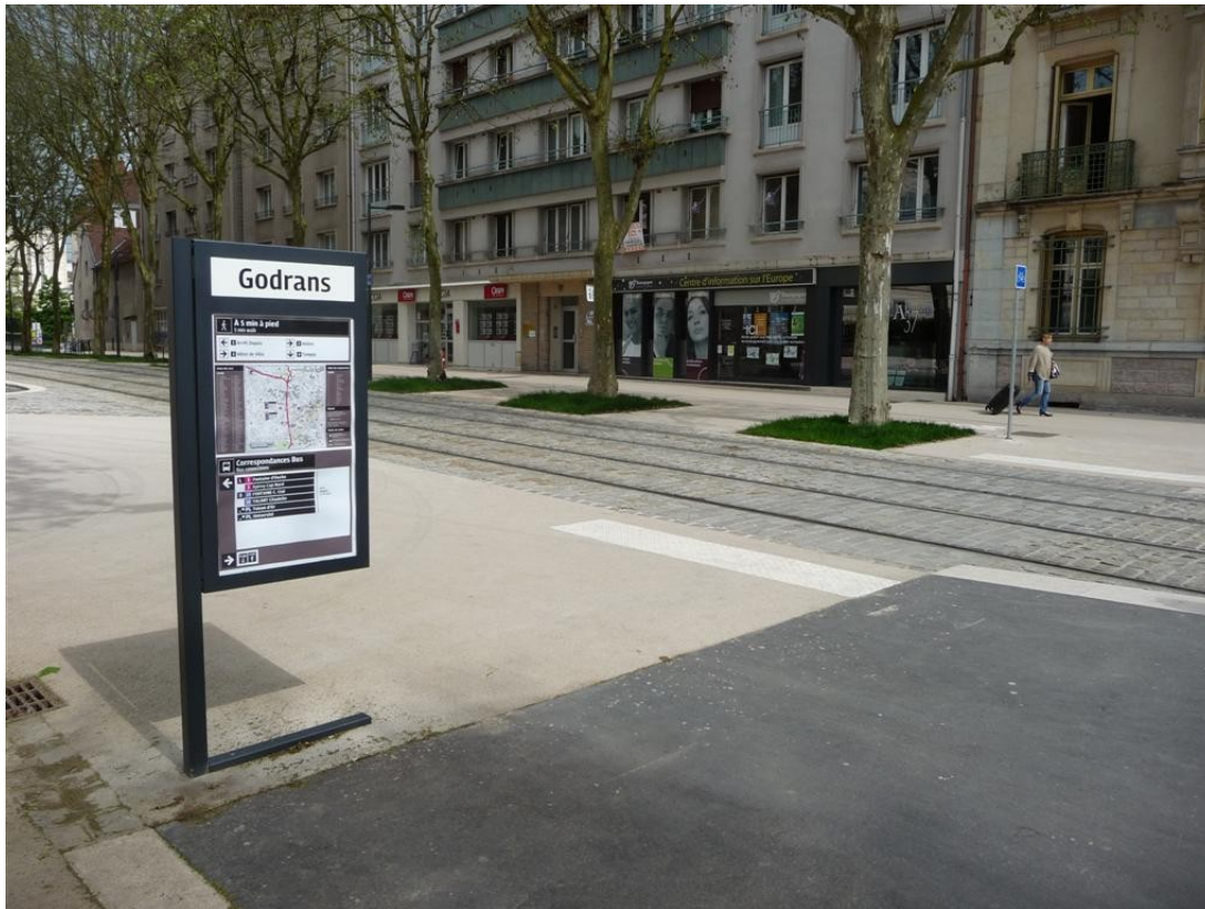
Début de station avec passage piétons, et pente progressive de quai
