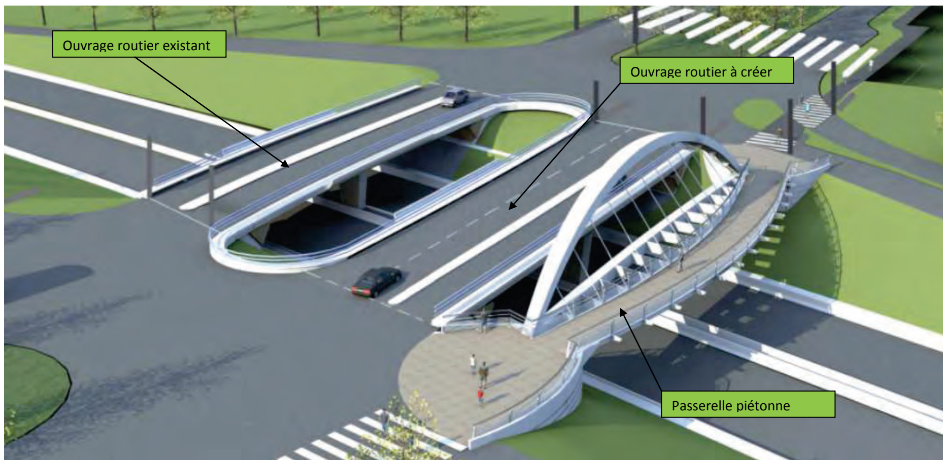
Echangeur avec gestion des tourne-à-gauche par feux tricolore. Passerelle piétonne de type « bow string »
