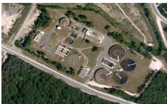
Vue aérienne de la station d'épuration de Chevigny-Saint-Sauveur
