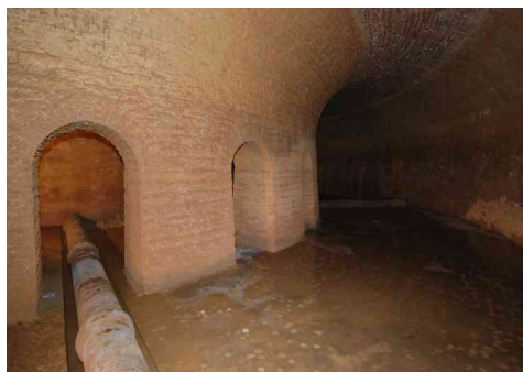
Réservoir Darcy – vue intérieure
