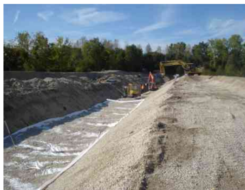
Travaux de réhabilitation de la tranchée drainante du champ captant de Couternon au mois de septembre 2011
