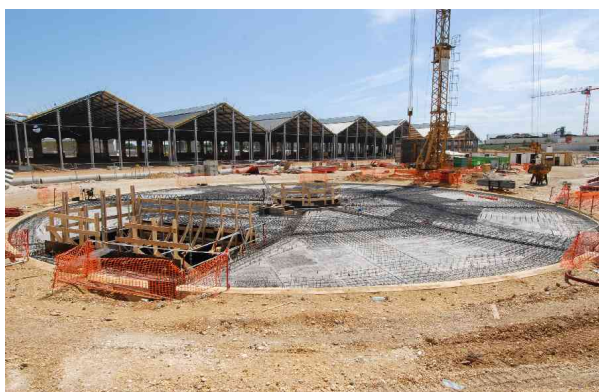
Travaux de construction du bassin de rétention de 5 000 m 3
