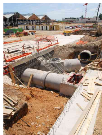
Travaux de construction du bassin de rétention de 5 000 m 3
