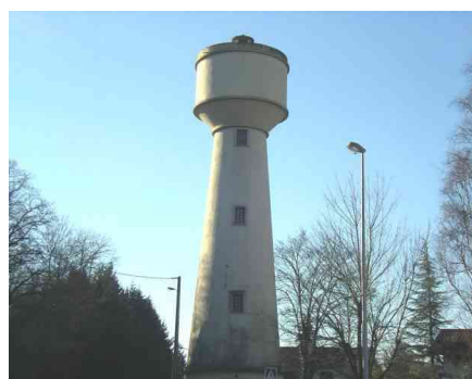
Réservoir de Couternon
