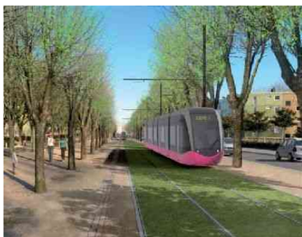
Plateforme engazonnée du Tram
