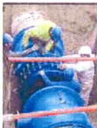
Mise en œuvre du branchement eau sur la conduite Bonna DN 10000
