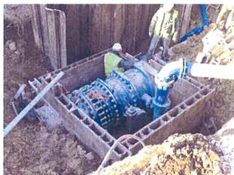
Création d'un branchement sur la conduite de 1 mètre de diamètre
