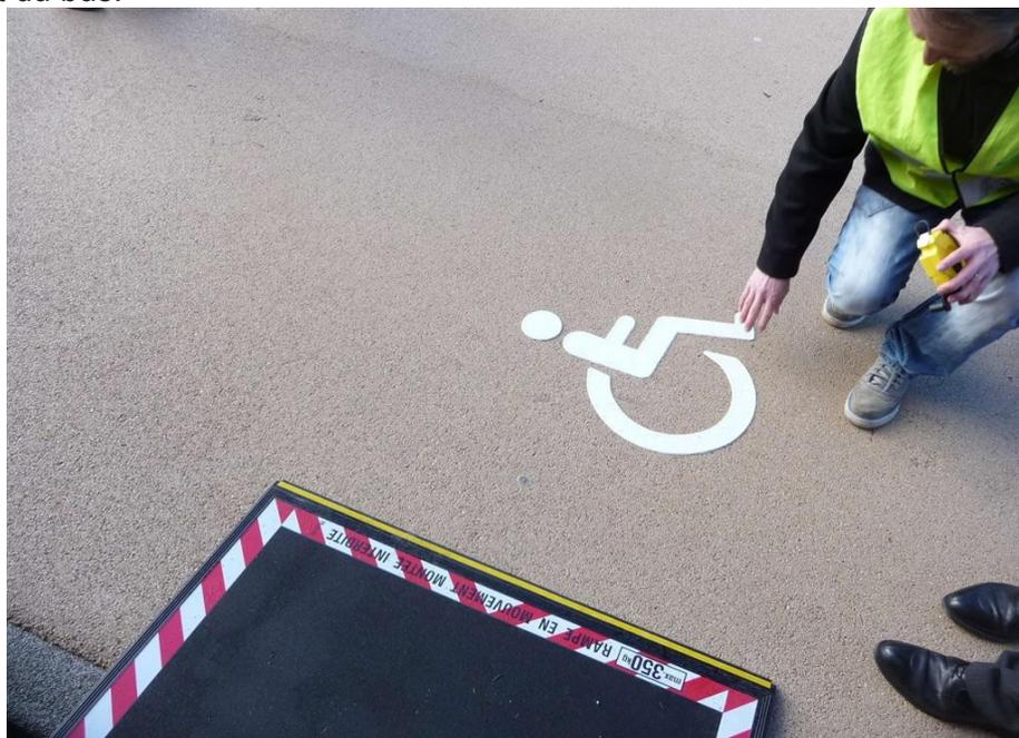
Le pictogramme « handicap » est destiné à être mis en face de la porte centrale équipée de la rampe d'accès.
